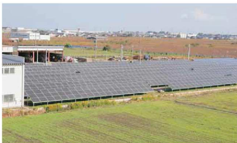
▲リョーシン東老田工場敷地内に新たに設置された太陽光パネル
